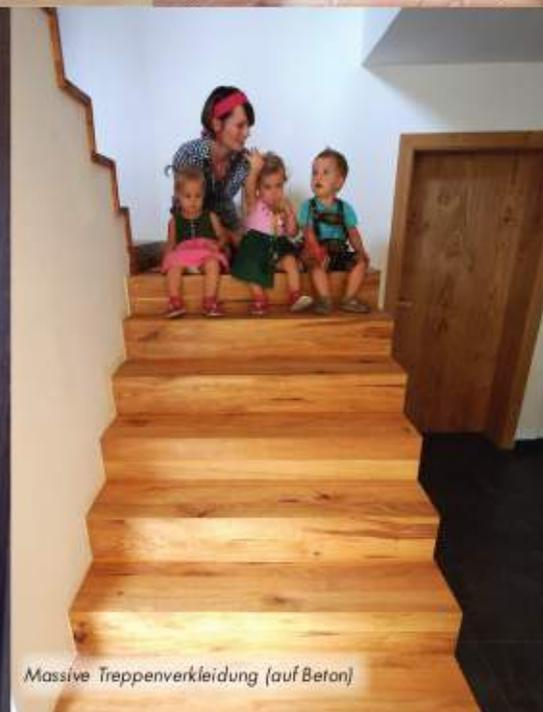
Massive Treppenverkleidung (auf Beton)
